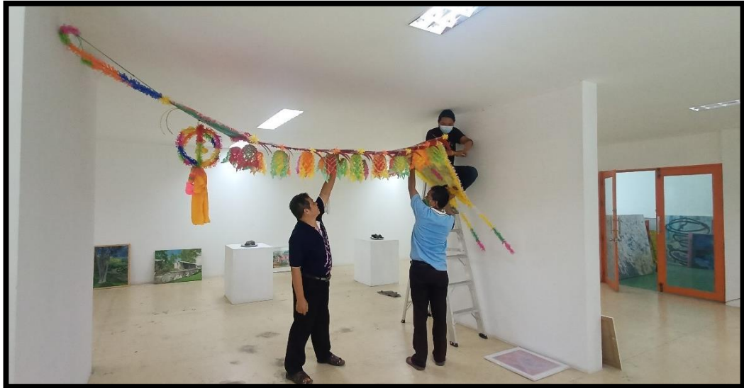
ภาพที่ ๓.๓๗ การติดตั้งผลงานภูมิปัญญาท้องถิ่น
