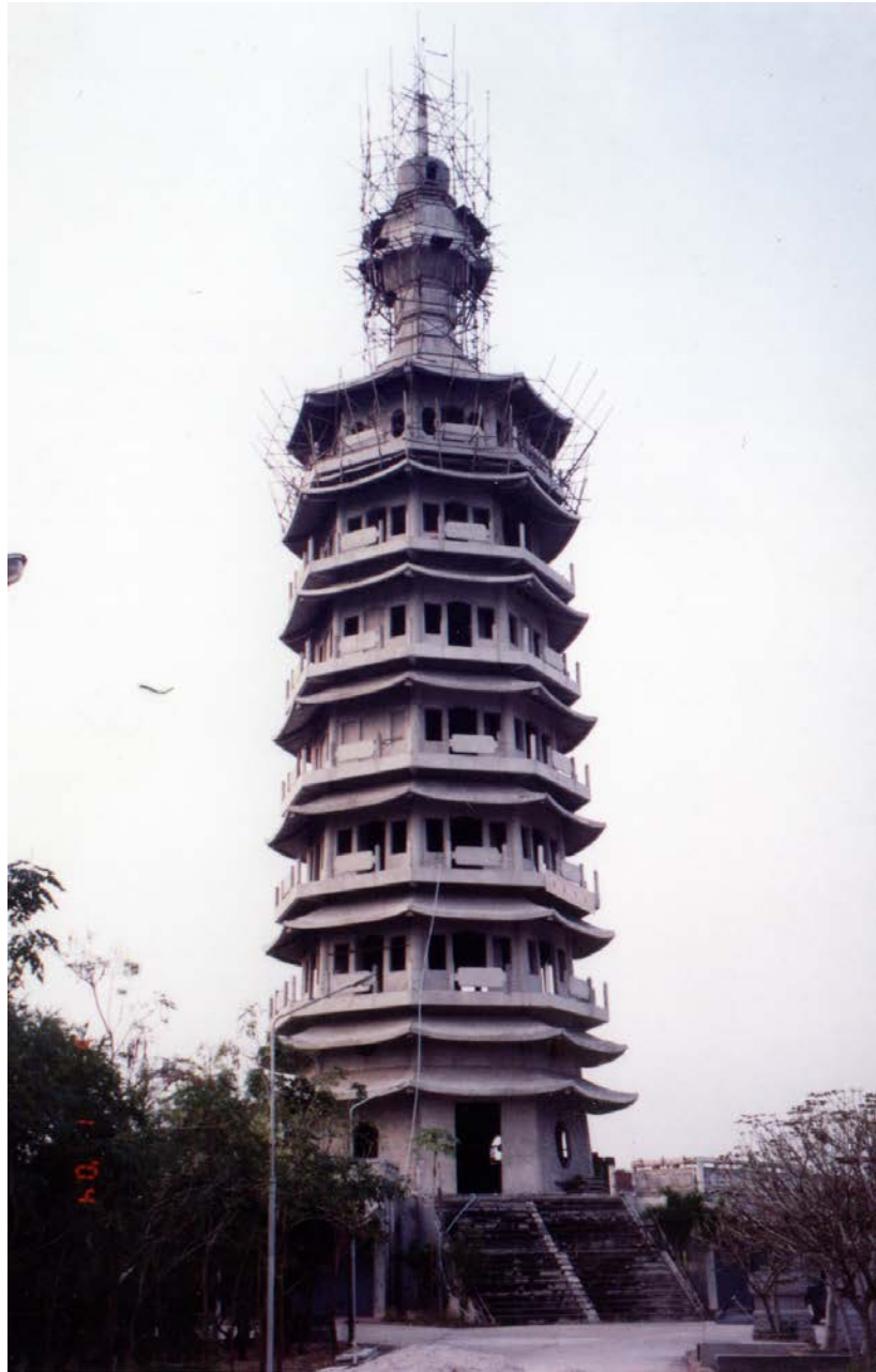
เจดีย์ที่กำลังก่อสร้าง ในปี ๒๕๔๓
